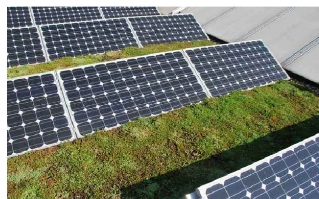
Extensive et panneaux photovoltaïques
