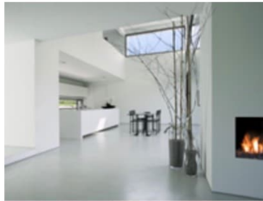
Béton lissé (revêtement intérieur)
