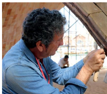
Figure 73 : Carlos Martin working on the Droneport, (« A'A » 2016)
